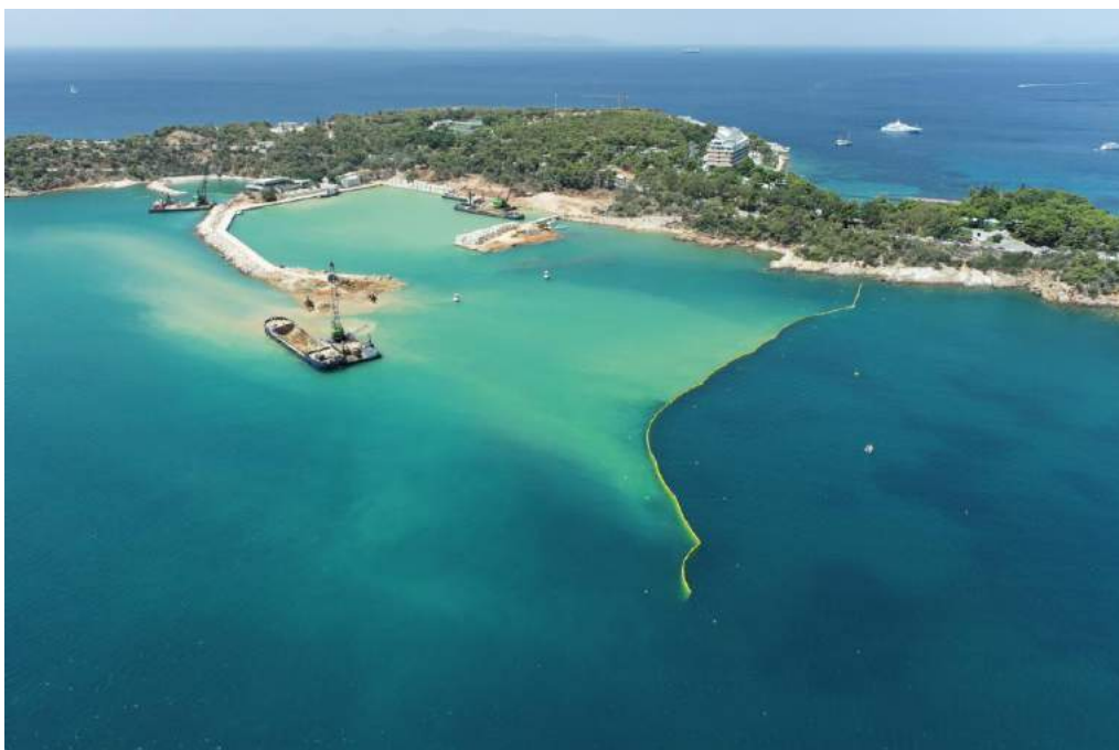
Εικόνα 8: Εναέρια φωτογραφία που δείχνει τη συγκράτηση του παραγόμενου νεφελώματος από τις εργασίες εκσκαφής/βυθοκόρησης της 15 ης Ιουλίου 2021 στη βόρεια προστατευτική κουρτίνα ιλύος (silt curtains).
