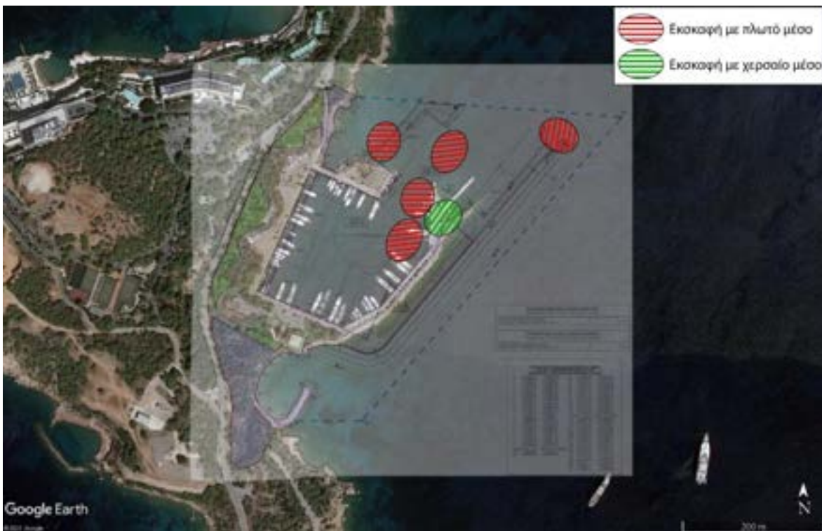
Εικόνα 4: Ενεργές εκσκαφές/βυθοκορήσεις στην περιοχή των έργου της Μαρίνας Βουλιαγμένης κατά τη διάρκεια της 30ης Ιουνίου 2022.
